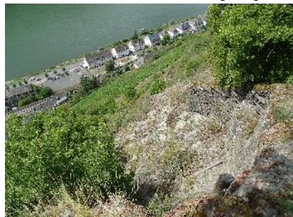
Abb. 5: Am „Rheinsteig“: Felsen und Weinbergsmauern oberhalb Kaub
